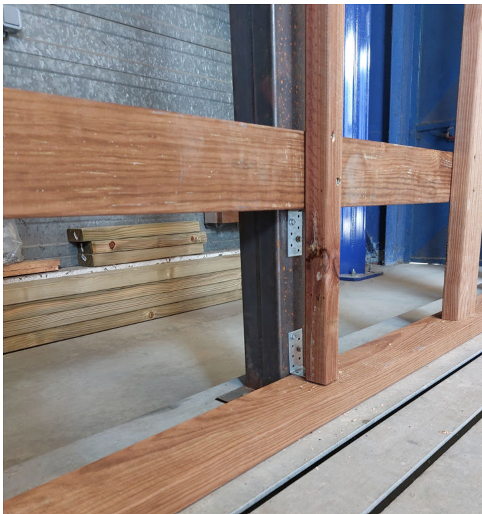
Photo 3 : Equerres de fixations structure support en bois
