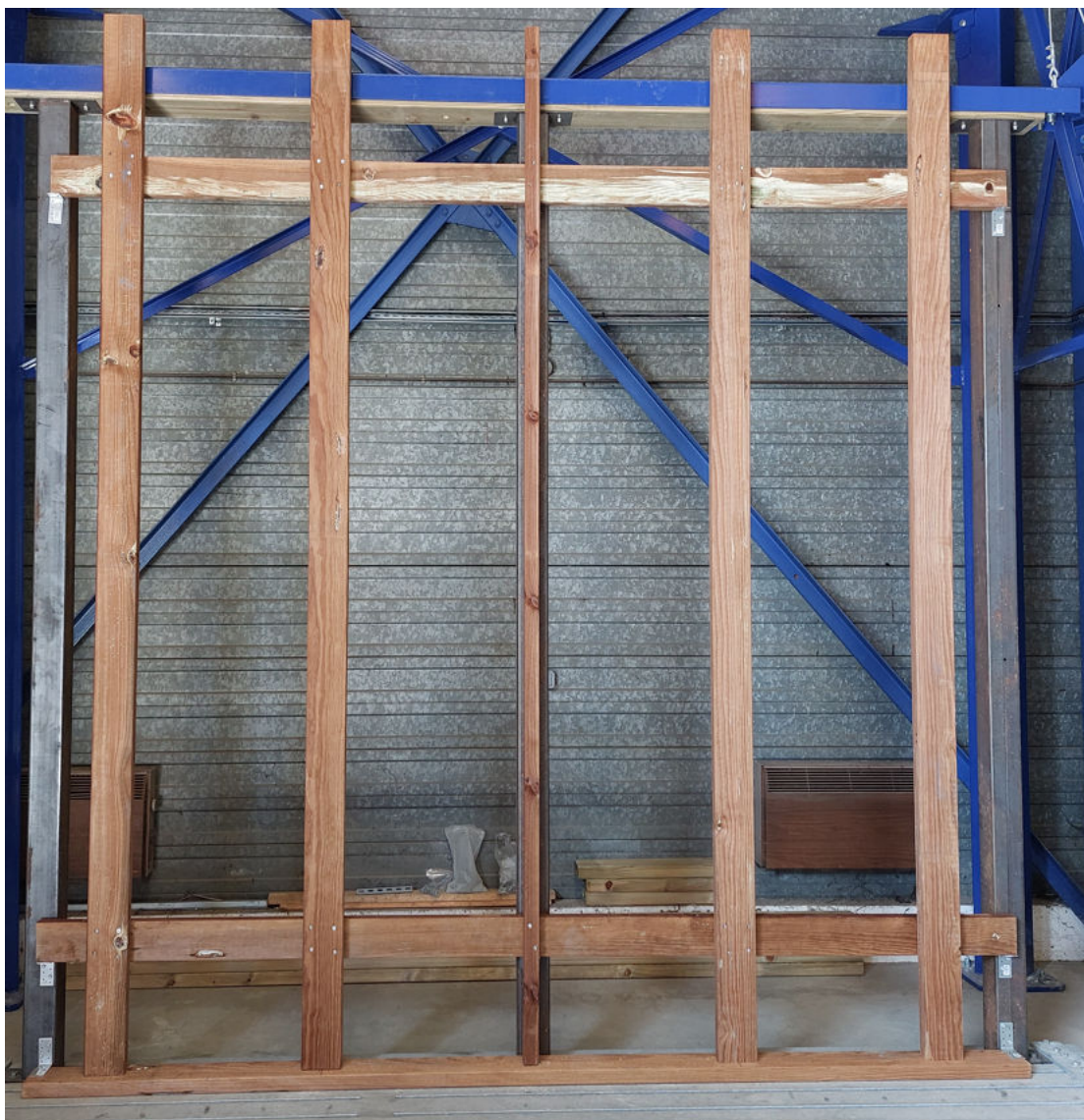
Photo 2 : Montage de la structure support en bois
